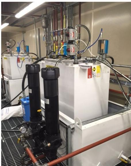
Tanques hidráulicos com filtros duplex em linha LMD 431
